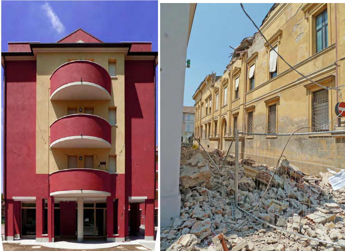
Fig. 14 – A sinistra, Rovereto, lesioni di livello 3 ad edificio in c.a. A destra, Mirandola, crollo parziale dei sottotetti di un edificio in laterizio del centro storico (foto 29 Maggio).
