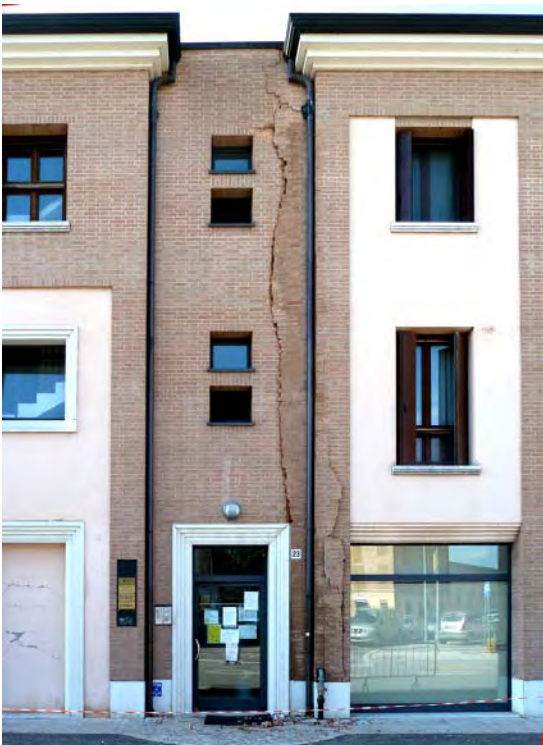
Fig. 8 – A sinistra, Cavezzo, 22 Maggio 2012: lesioni 3-4 al giunto di un condominio in c.a. del centro storico, successivamente crollato con la scossa del 29 Maggio. A destra, Mirandola, 21 Maggio: schiacciamento di un pilastro in c.a. in un condominio del centro storico.
