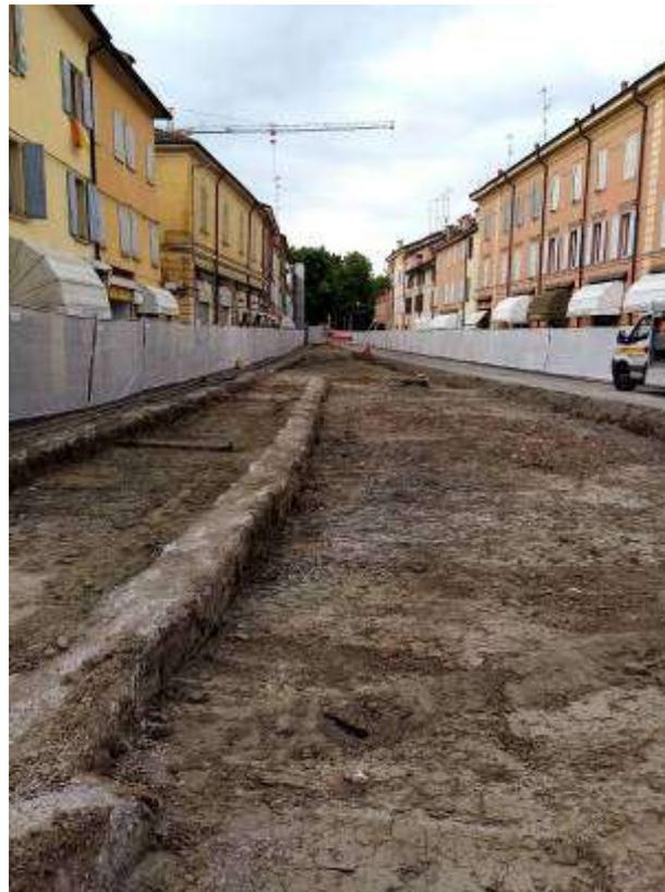
Fig. 3 – Scavo di sbancamento del lato est
