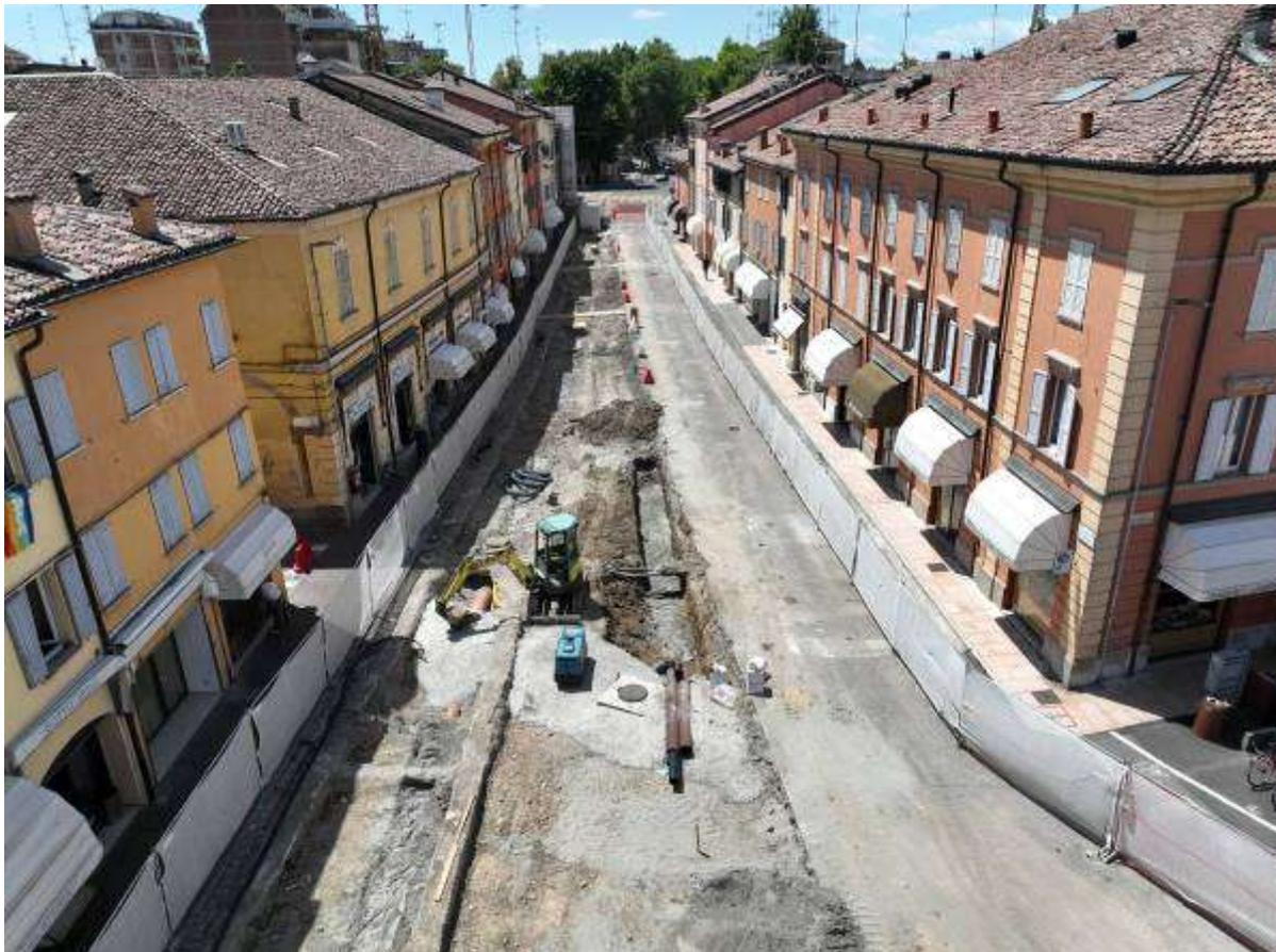
Fig. 1 – Vista generale dell'area di cantiere durante la posa delle reti dei sottoservizi
