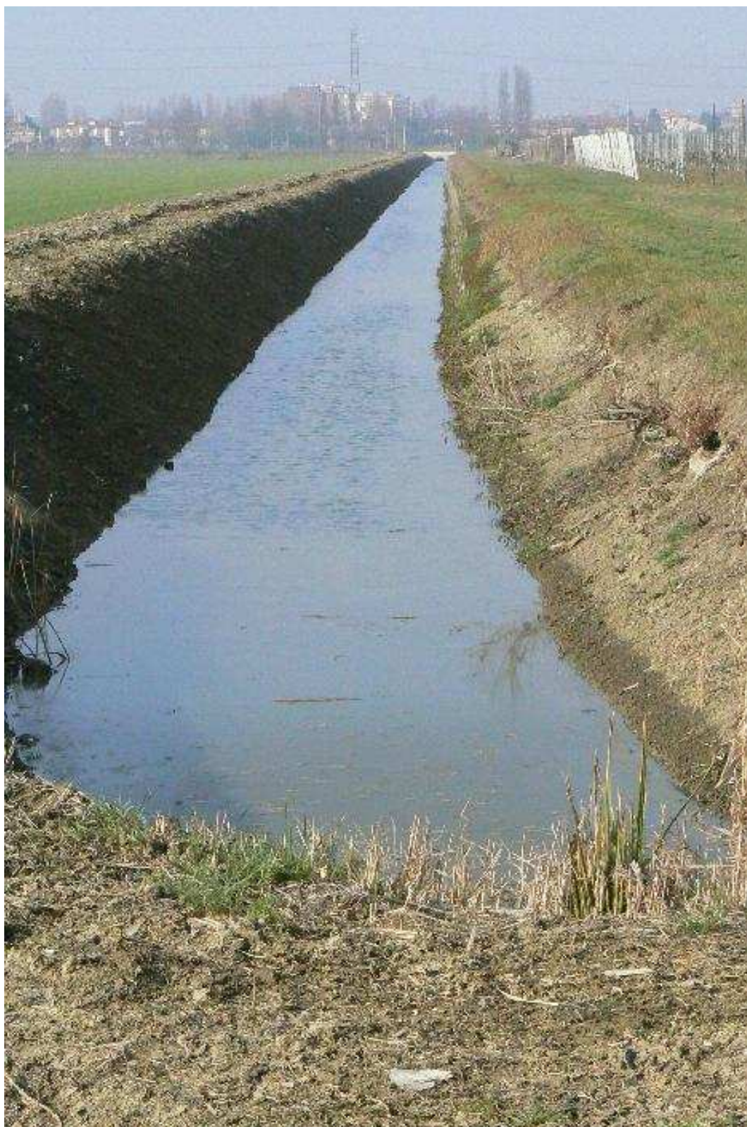
Foto n. 6: tratto del canale a ovest di Via Martiri Partigiani, ove permane la fascia di tutela di m. 50 per lato
