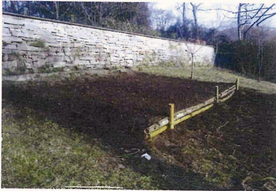
Al fine di ottenere una struttura a forma di parallelepipedo che costituisca un cordolo di contenimento dell'intera struttura, si procederà per livelli con basi di contenimento costituite da pali ed assicelle in legno il cui perimetro sarà progressivamente più contenuto man mano che si alzerà il livello del cordolo stesso.
