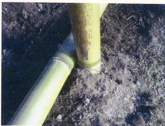
Lo scopo della struttura in legno fondamentale è costituita da tronchi di varie sezioni interrati verticalmente a sostegno di altri tronchi posti orizzontalmente a ridosso dei precedenti interrati, è quello di rendere la struttura meno soggetta a progressivi smottamenti che ne diminuirebbero con il tempo e le precipitazioni atmosferiche la capacità contenitiva.
