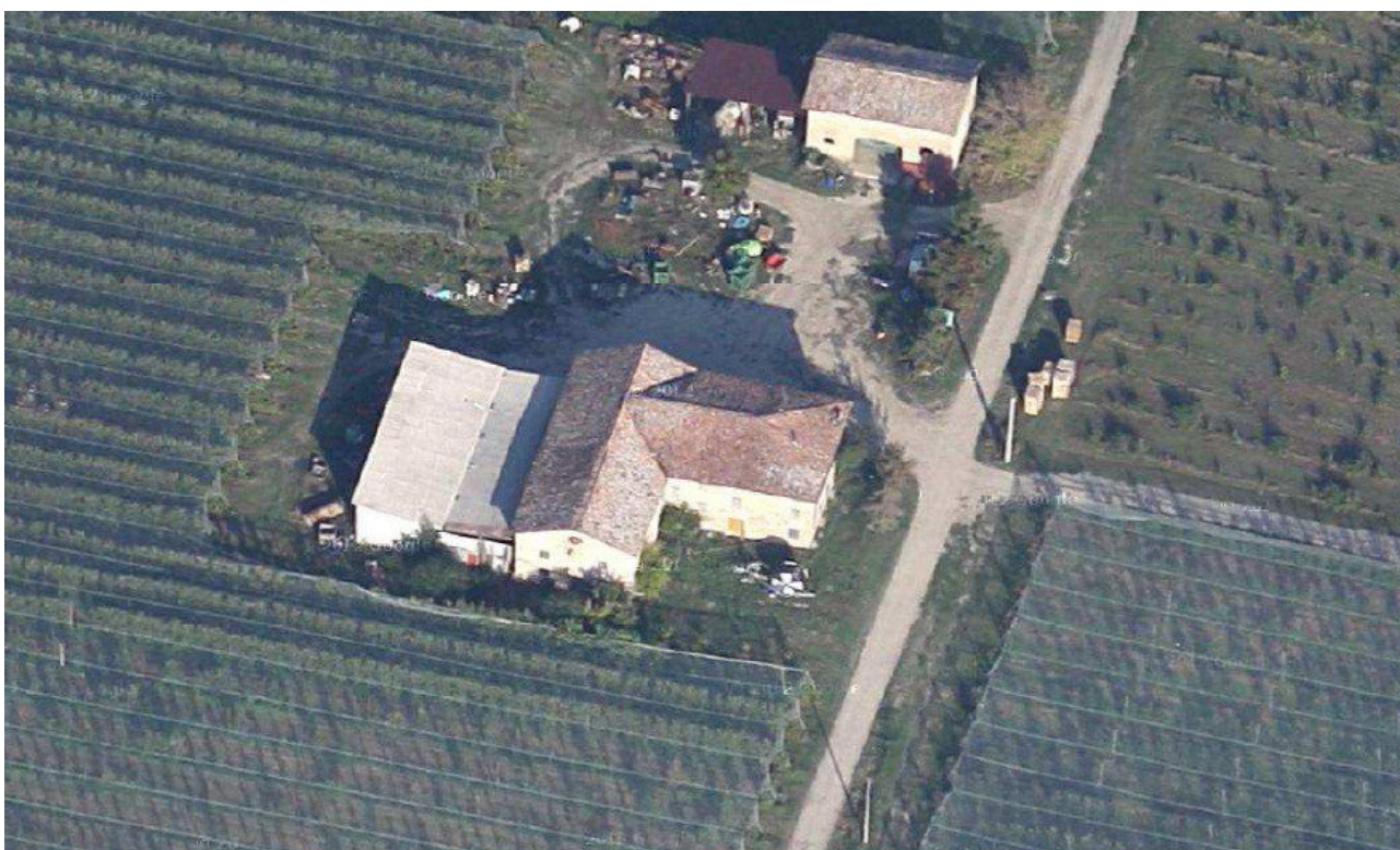
Vista della corte colonica da nord (Fonte Google maps)
