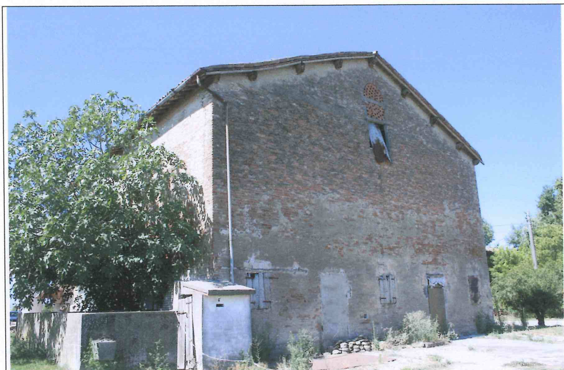
Foto n.1 – fronte nord ovest
