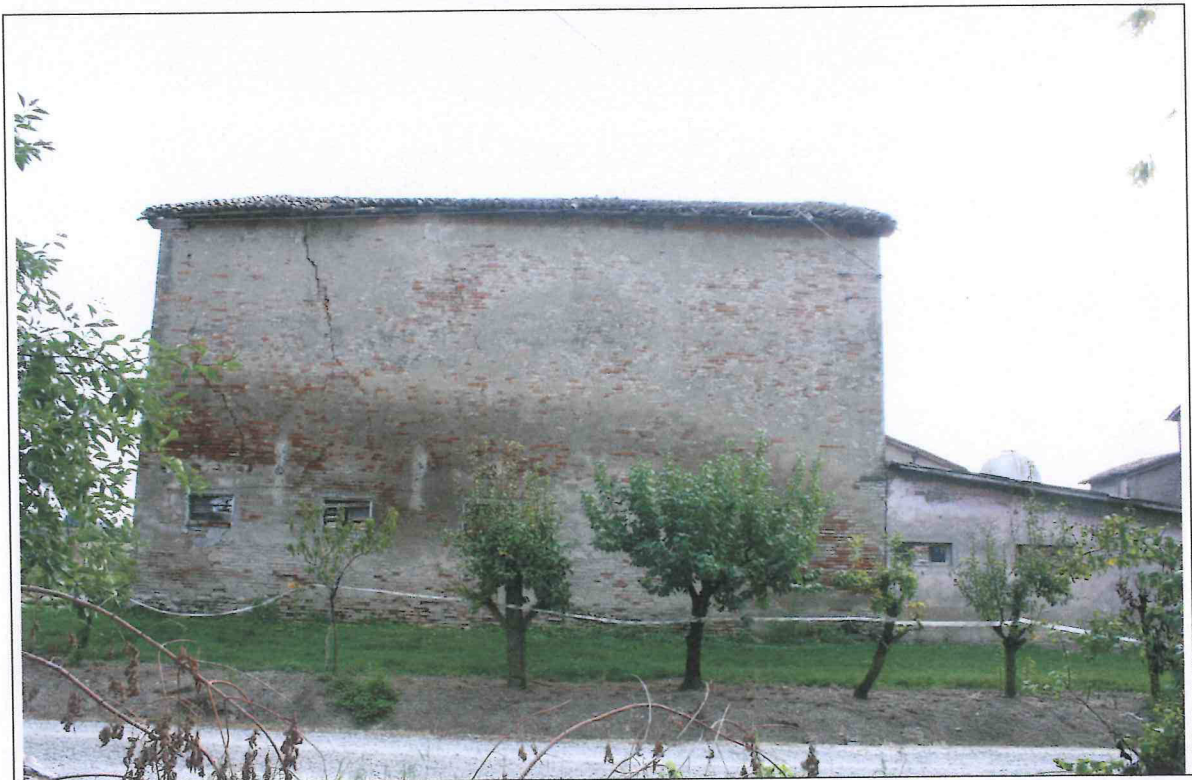
Foto n.3 - fronte nord est
