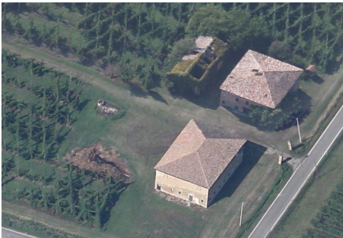
Vista della corte da est (Fonte Google maps)
