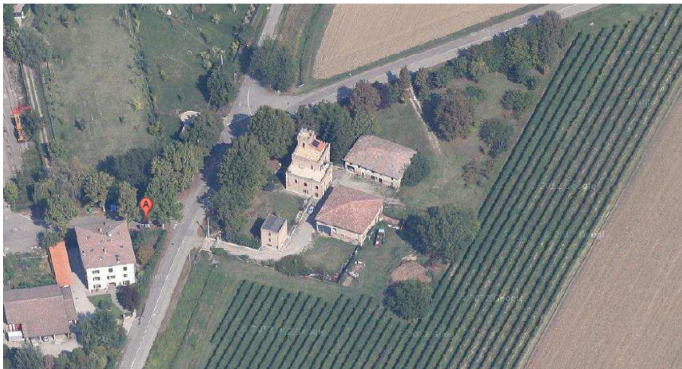
Vista della corte colonica da sud (Fonte Google maps)
