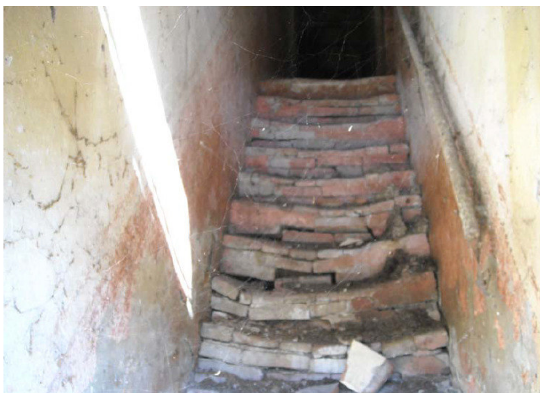
Documentazione fotografica: particolare della scala interna (2013)
