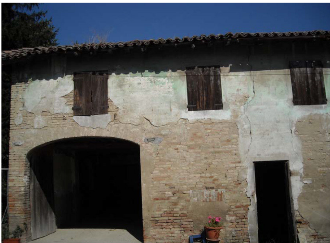
Documentazione fotografica: Prospetto sud (2013)
