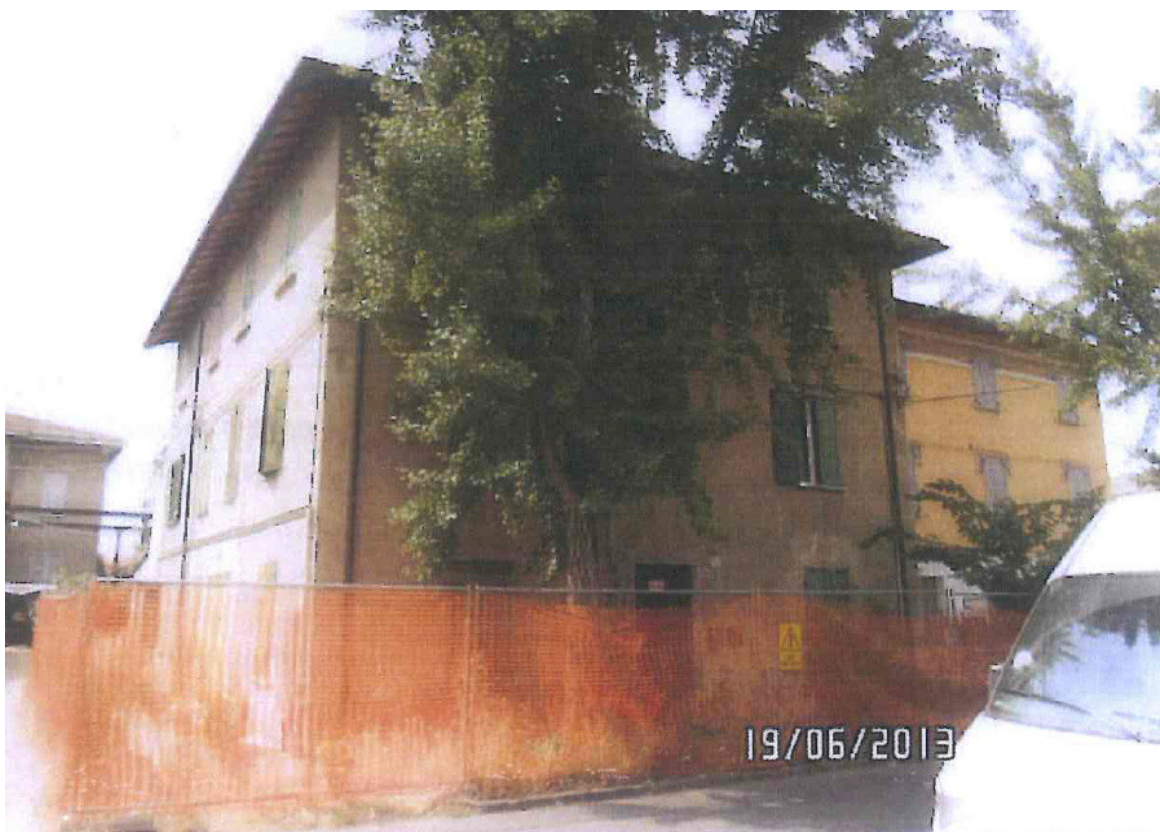
Documentazione fotografica: Prospetti est e sud (2013)
