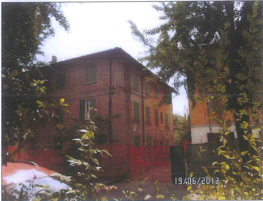
01. VISTA DA VIA MATTEOTTI
