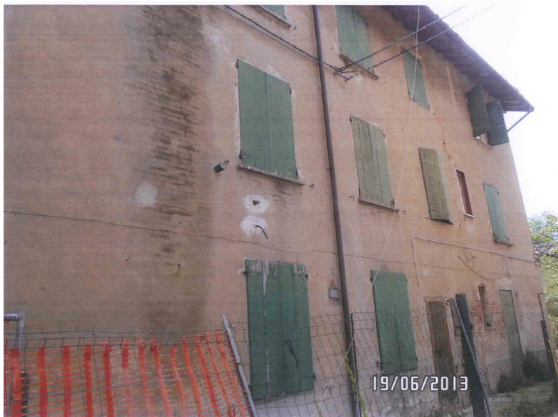
Documentazione fotografica: Prospetto nord (2013)
