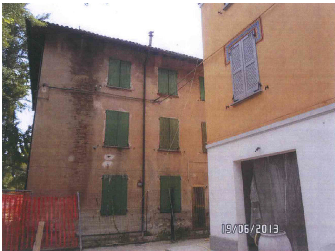
Documentazione fotografica: Prospetto nord (2013)
