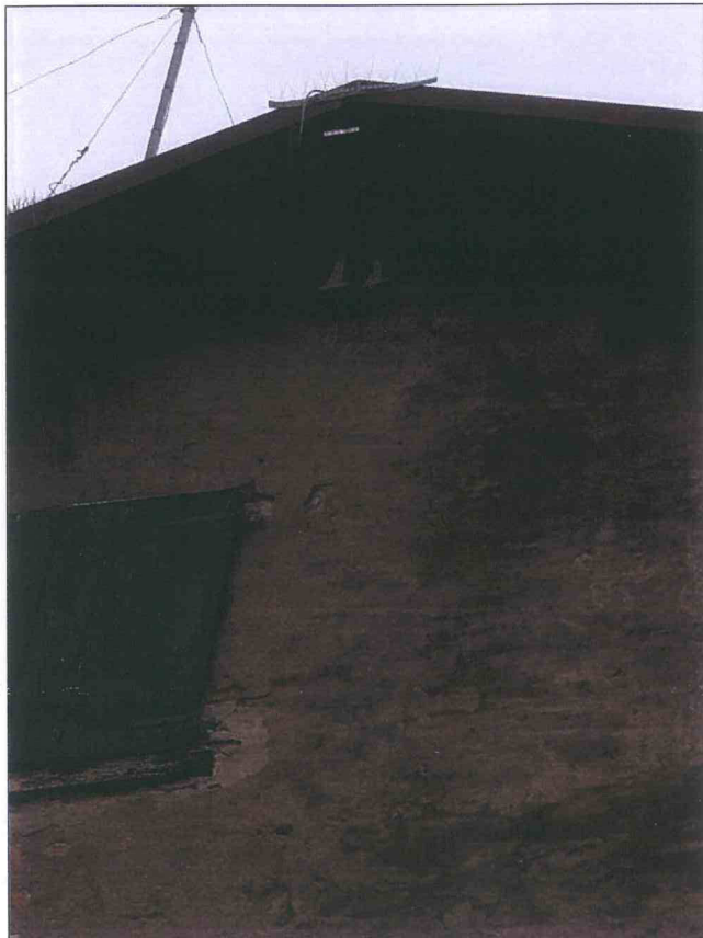
06. LATO OVEST - PARTICOLARE COLMO
