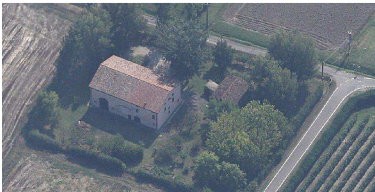
Vista del fabbricato da nord ovest (Fonte Google maps)
