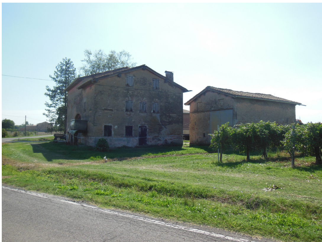
Documentazione fotografica: Vista da Via Serrasina, nord ovest (settembre 2013)
