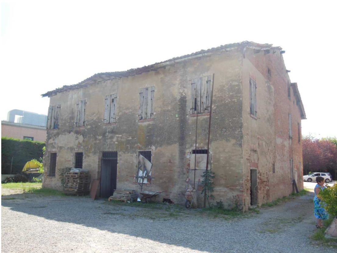
Documentazione fotografica: Prospetto ovest (settembre 2013)
