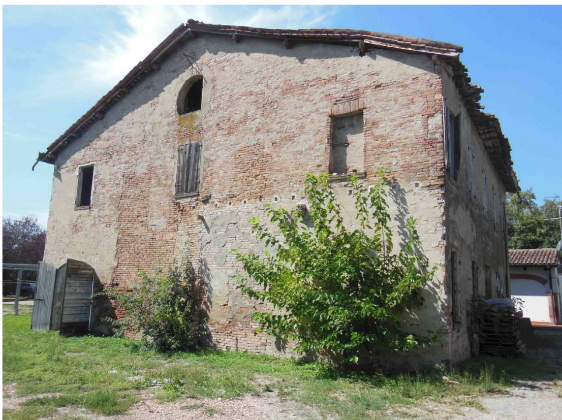
Documentazione fotografica: Prospetto nord est (settembre 2013)
