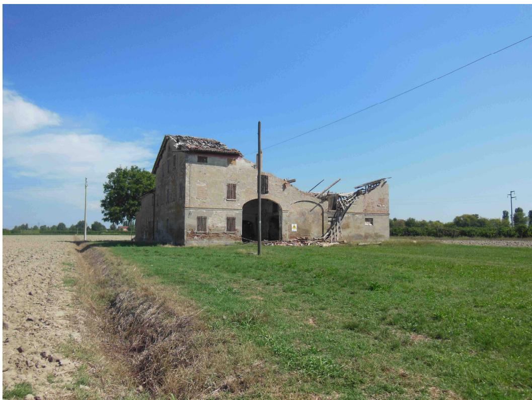
Documentazione fotografica: Vista da Via Serrasina (settembre 2013)
