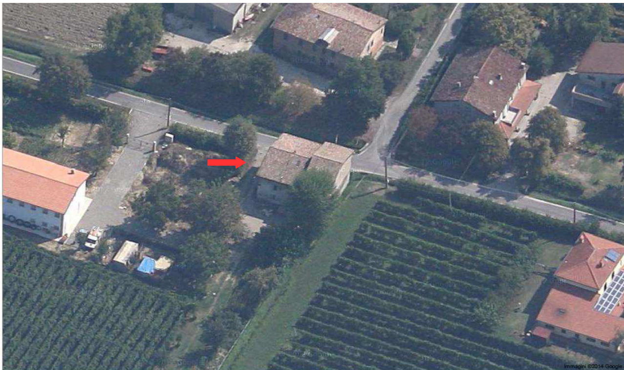
Vista del fabbricato da sud ovest (Fonte Google maps)
