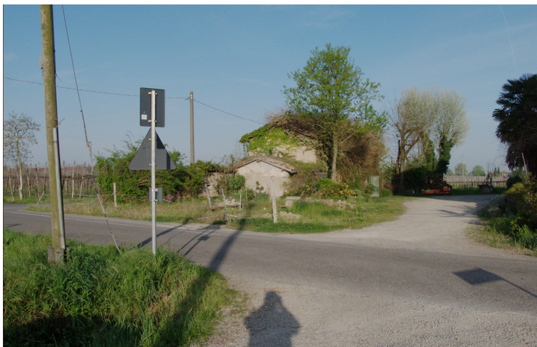
Documentazione fotografica attestante l'avvenuta demolizione (marzo 2014)
