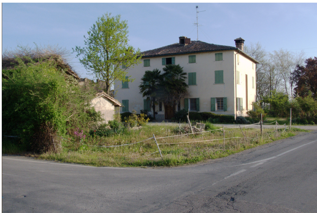
Documentazione fotografica attestante l'avvenuta demolizione (marzo 2014)
