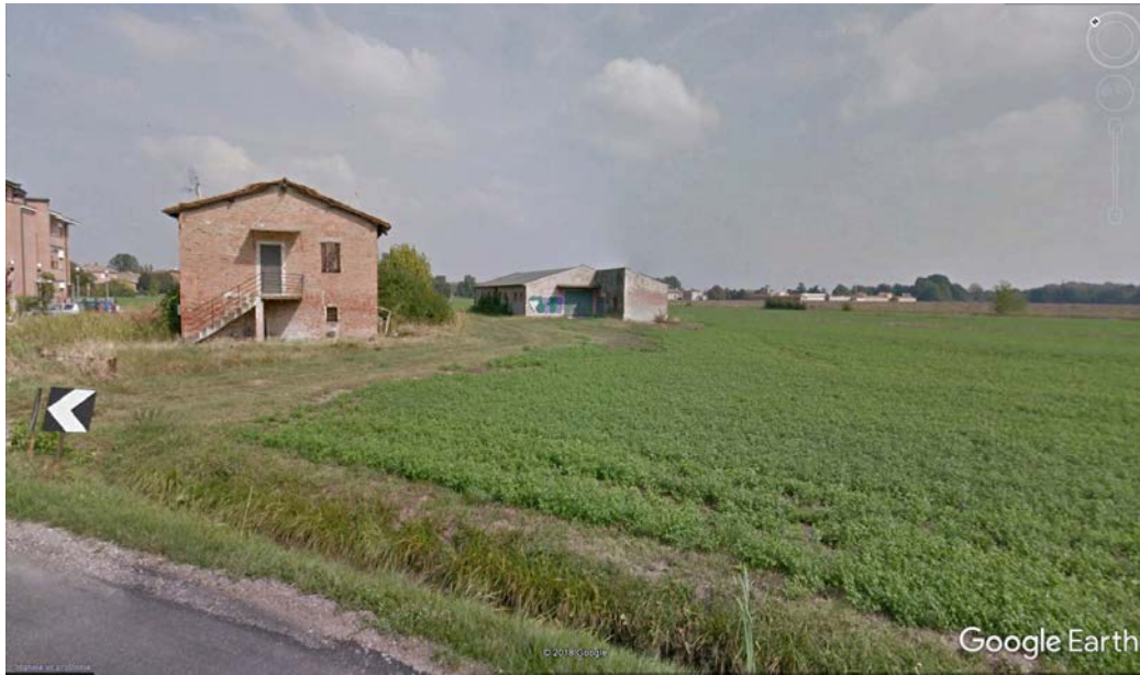
Fig. 3.2: Ripresa fotografica dell'area vista da sud-est
