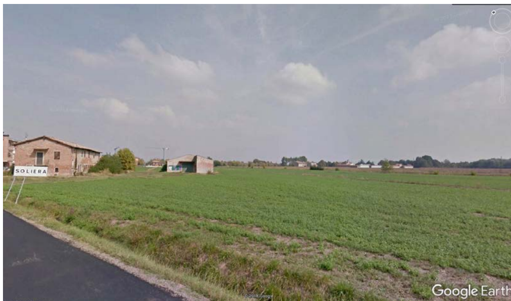
Fig. 3.1: Ripresa fotografica dell'area vista da sud-est
