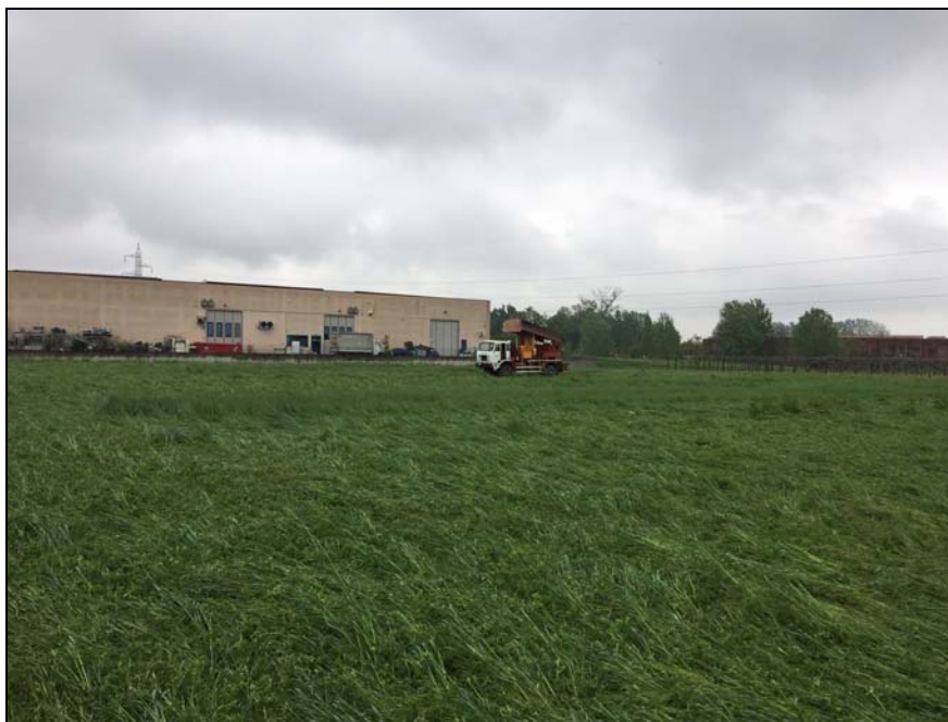
Ripresa fotografica dell'esecuzione delle prove penetrometriche nell'area di indagine.
