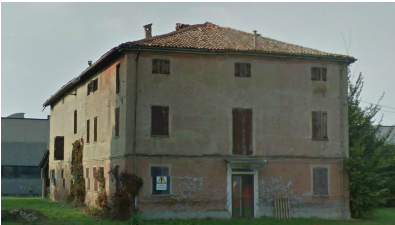
Fig. 5: Stato di fatto, fronte Sud-Est e Sud-Ovest
