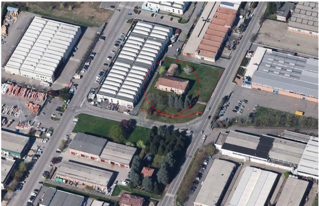
Localizzazione del fabbricato oggetto di Variante su vista aerea
