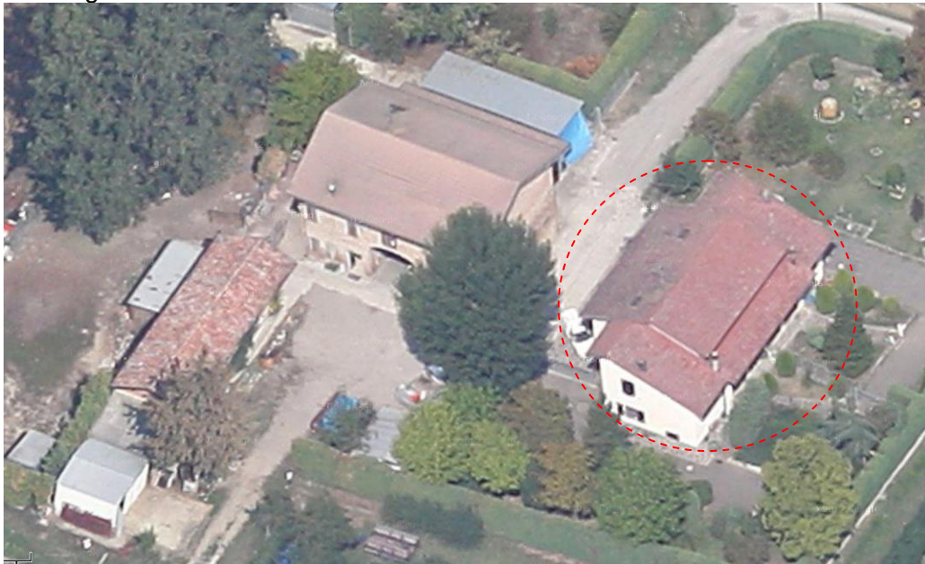
Localizzazione del fabbricato oggetto di Variante su vista aerea
