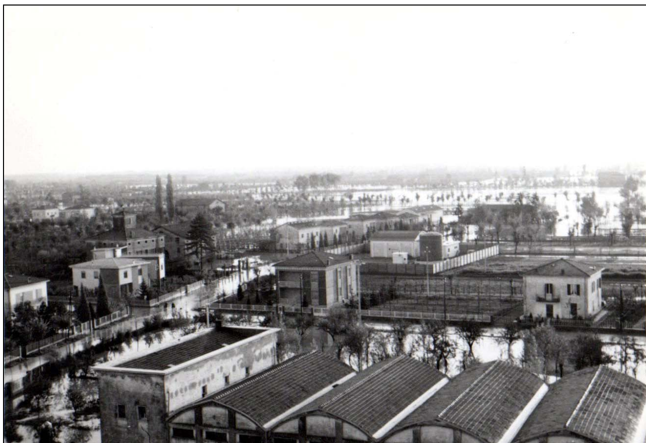
Fig. A17 – Soliera, Novembre 1966, Vista in direzione Est dal tetto del "palazzone".
