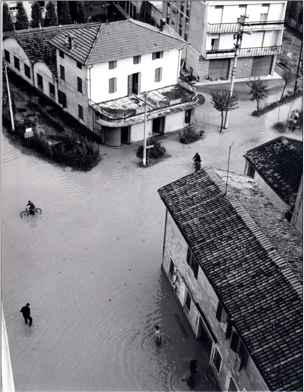
Fig. A12 – Soliera, Novembre 1966, Via Grandi dal tetto del "palazzone".
