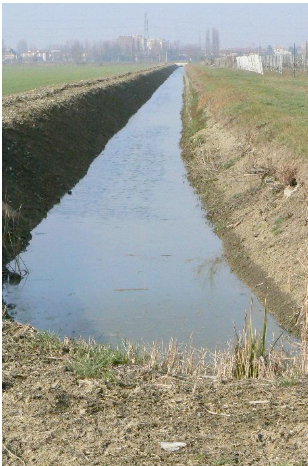
Foto n. 6: tratto del canale a ovest di Via Martiri Partigiani, ove permane la fascia di
