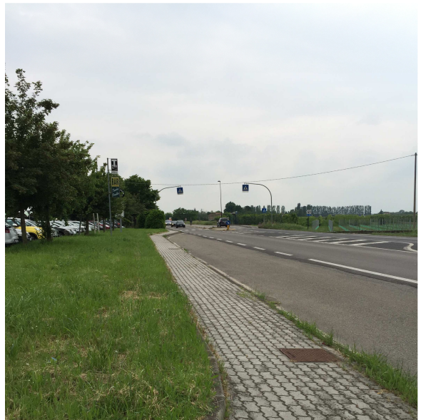
37U-04 ATTRAVERSAMENTO VIA MODENA – CARPI DIREZIONE MODENA
