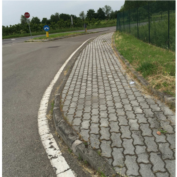
37U-02 MARCIAPIEDE DIREZIONE CARPI
