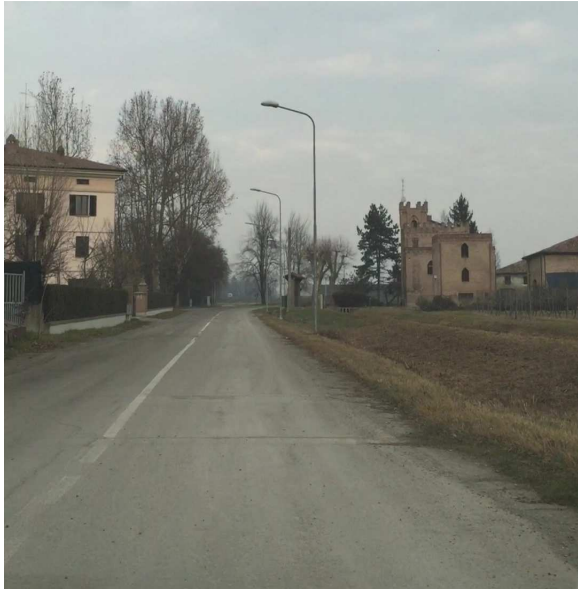
40U-01 ASSENZA DI MARCIAPIEDI
