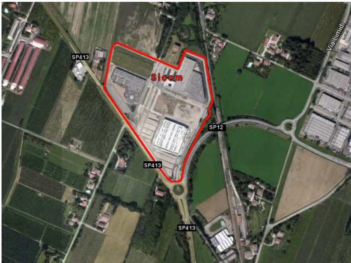
Fig. 12. La viabilità nella zona
