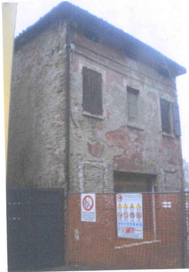
Foto n. 5 Prospetto su Via Papa Giovanni XXIII
