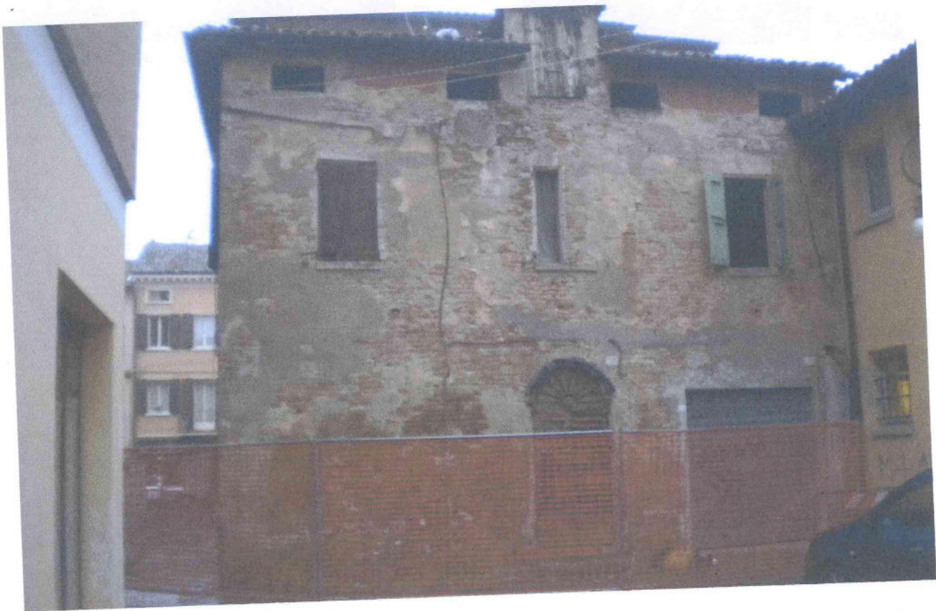
Foto n. 1 Prospetto principale lato ingresso
