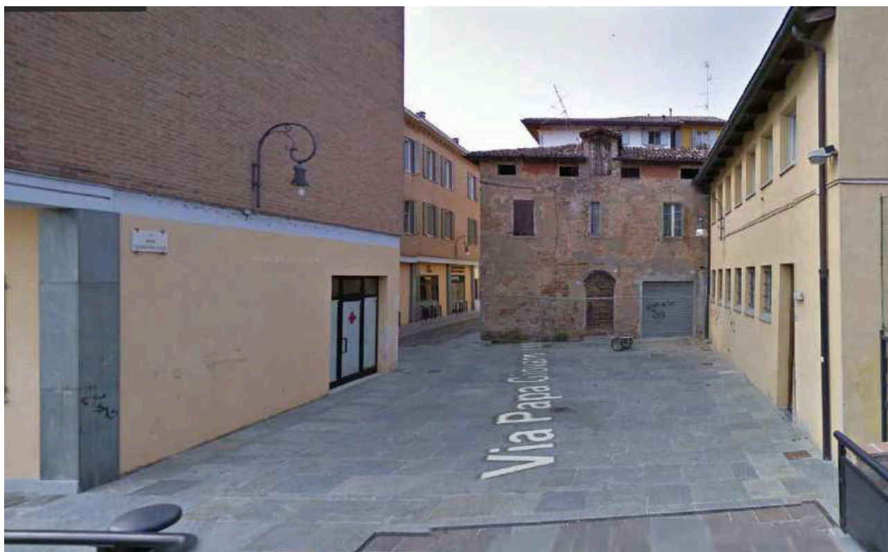
Prospetto est del complesso (Fonte Google maps)
