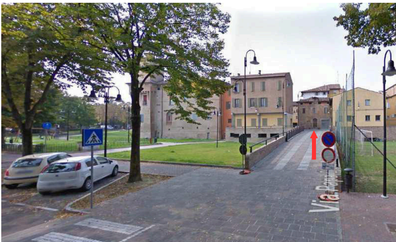
Vista del complesso da est (Fonte Google maps)
