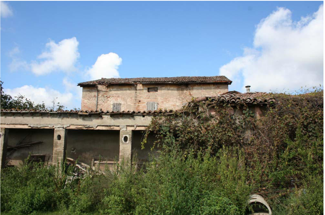
Foto 6 – porzione C - porticato esterno
