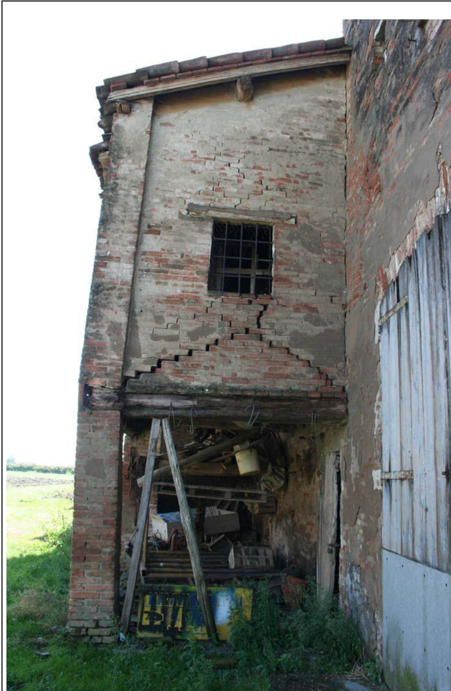
Foto n.2 – fronte nord ovest
