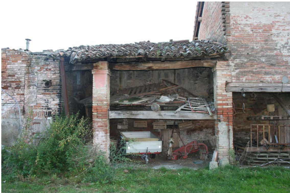
Foto 4 – porzione B - fronte sud ovest
