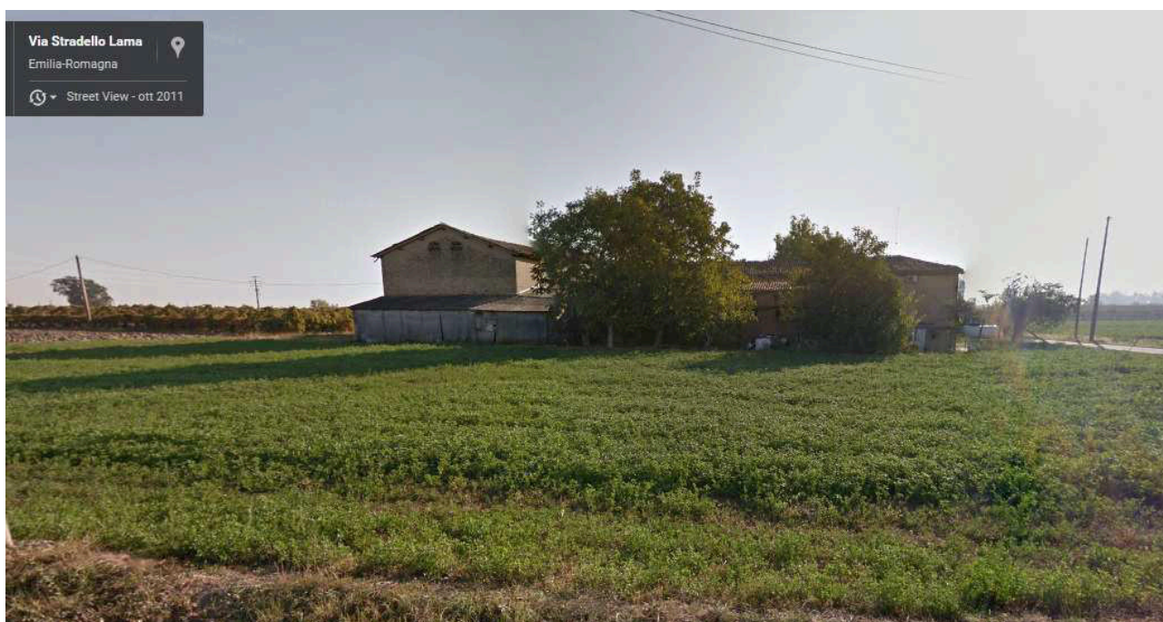
Vista della corte colonica da ovest (Fonte Google maps)
