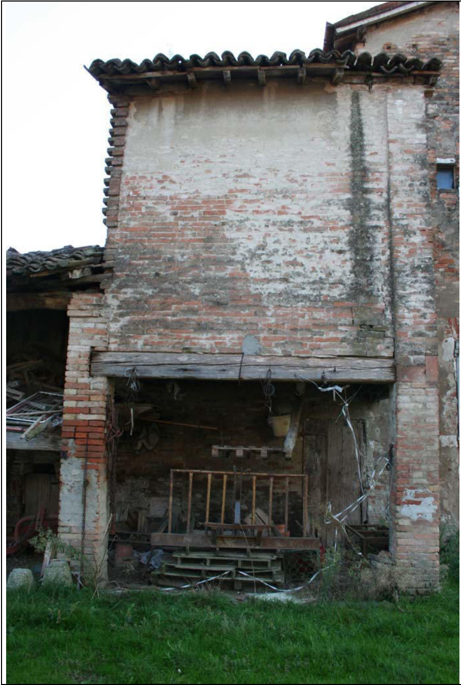
Foto n.3 – fronte nord est
