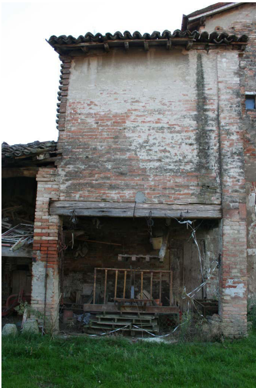
Foto 2 – porzione A fronte sud ovest
