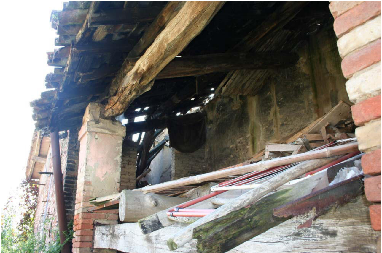
Foto 7 – porzione B - fronte sud ovest
