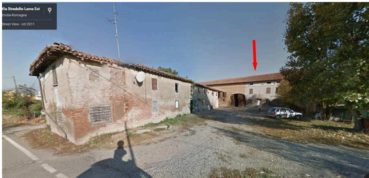
Vista della corte colonica da sud est (Fonte Google maps)
