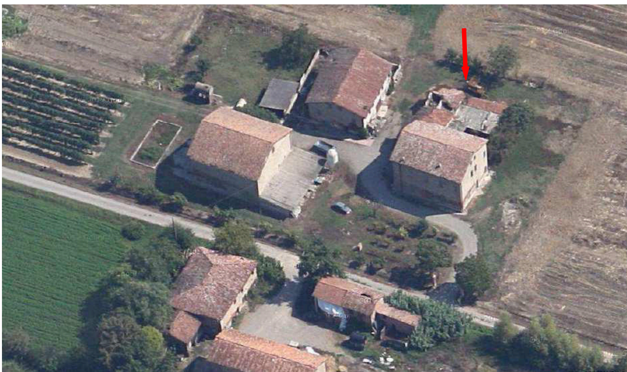
Vista della corte colonica da ovest (Fonte Google maps)
