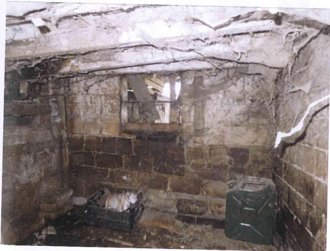
Stato manutentivo scarso, umidità di risalita
