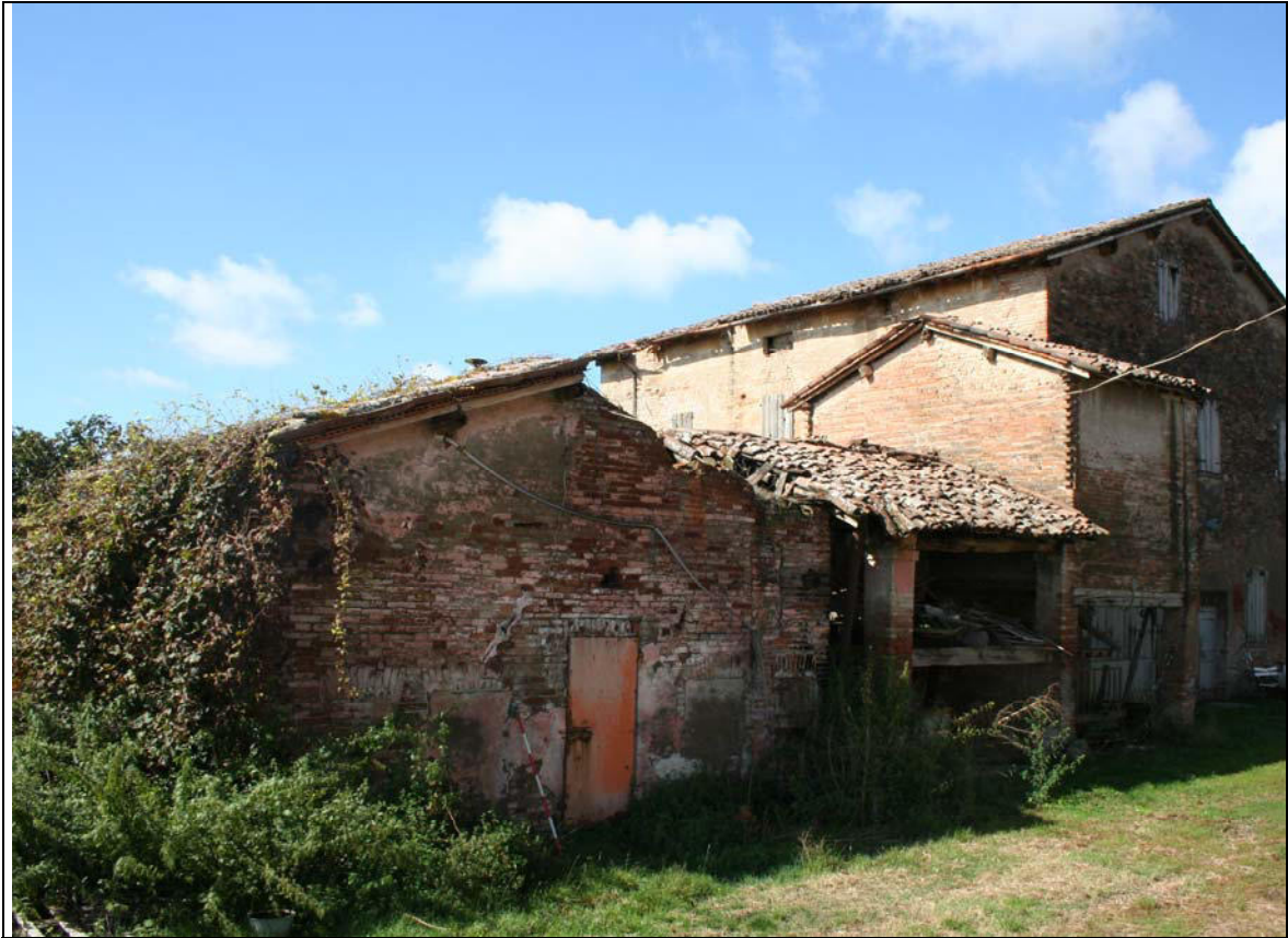
Foto n.4 - fronte nord est
