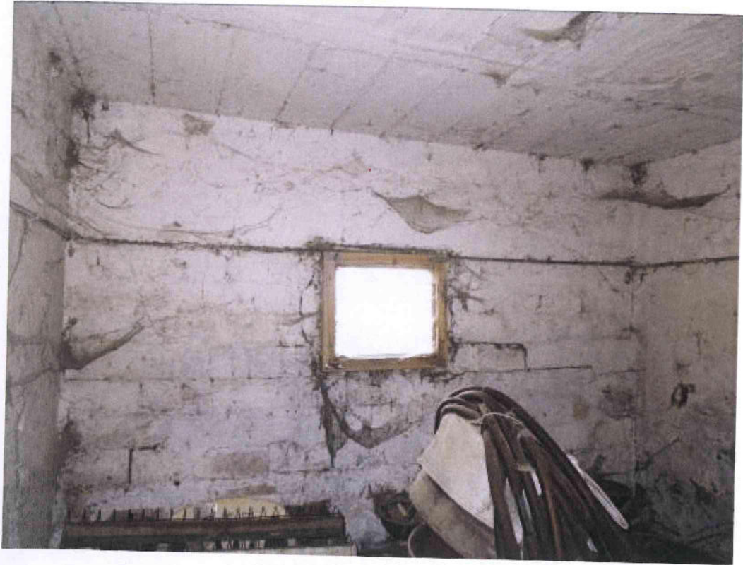
Stato manutentivo scarso, umidità di risalita
