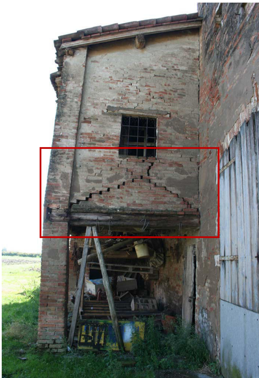
Foto 1 – porzione A - fronte nord ovest
