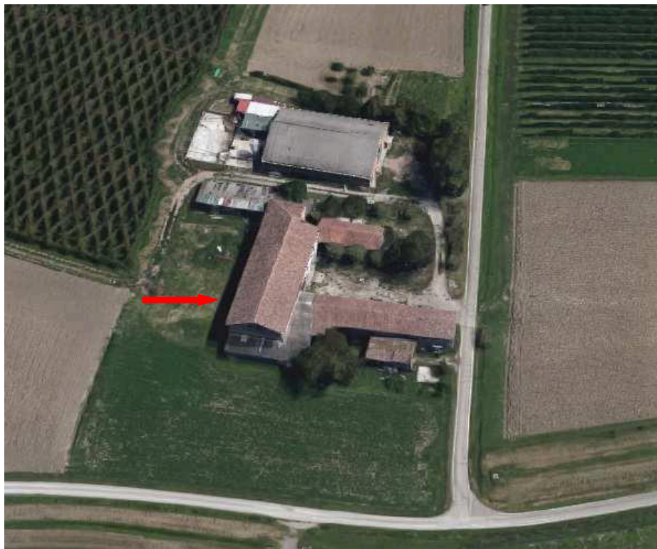
Vista della corte colonica da ovest (Fonte Google maps)
