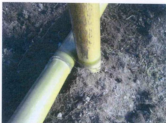
Lo scopo della struttura in legno fondamentale è costituita da tronchi di varie sezioni interrati verticalmente a sostegno di altri tronchi posti orizzontalmente a ridosso dei precedenti interrati, è quello di rendere la struttura meno soggetta a progressivi smottamenti che ne diminuirebbero con il tempo e le precipitazioni atmosferiche la capacità contenitiva.
