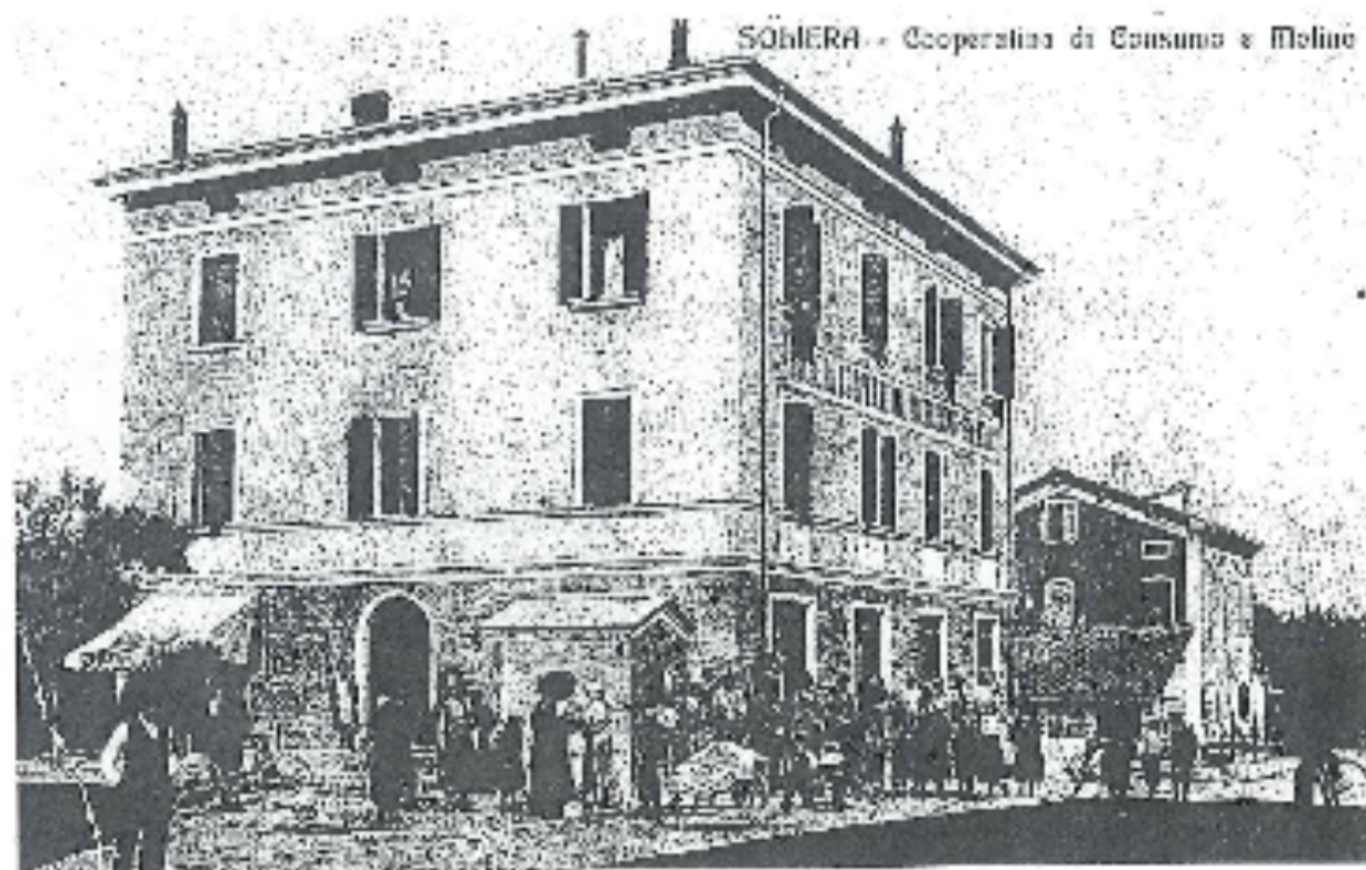
Casa Cooperativa col piccolo edificio della pest pubblica
