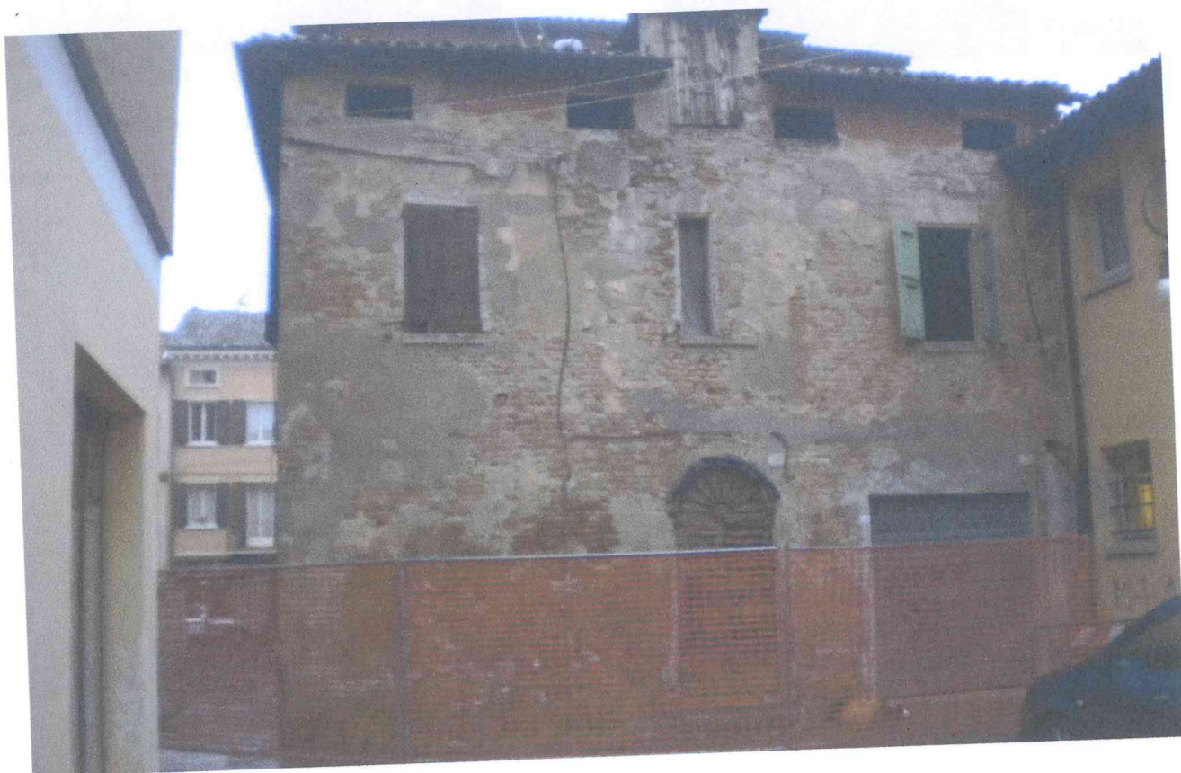
Foto n. 1 Prospetto principale lato ingresso
