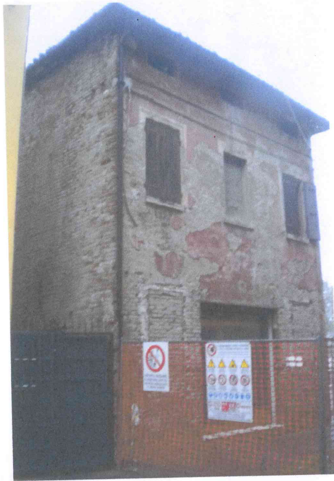
Foto n. 5 Prospetto su Via Papa Giovanni XXIII
