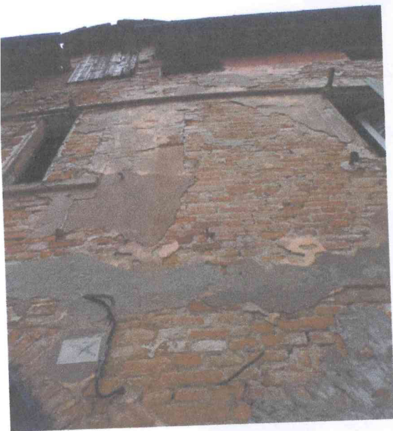
Foto n. 2 Particolare cinematismo parete verso esterno
