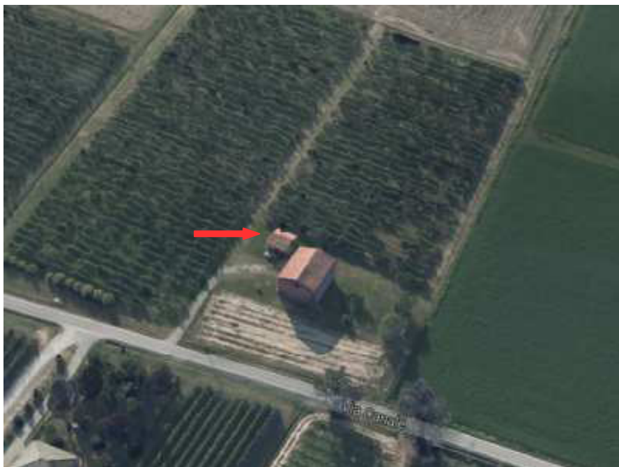
Vista del fabbricato da nord est (Fonte Google maps)
