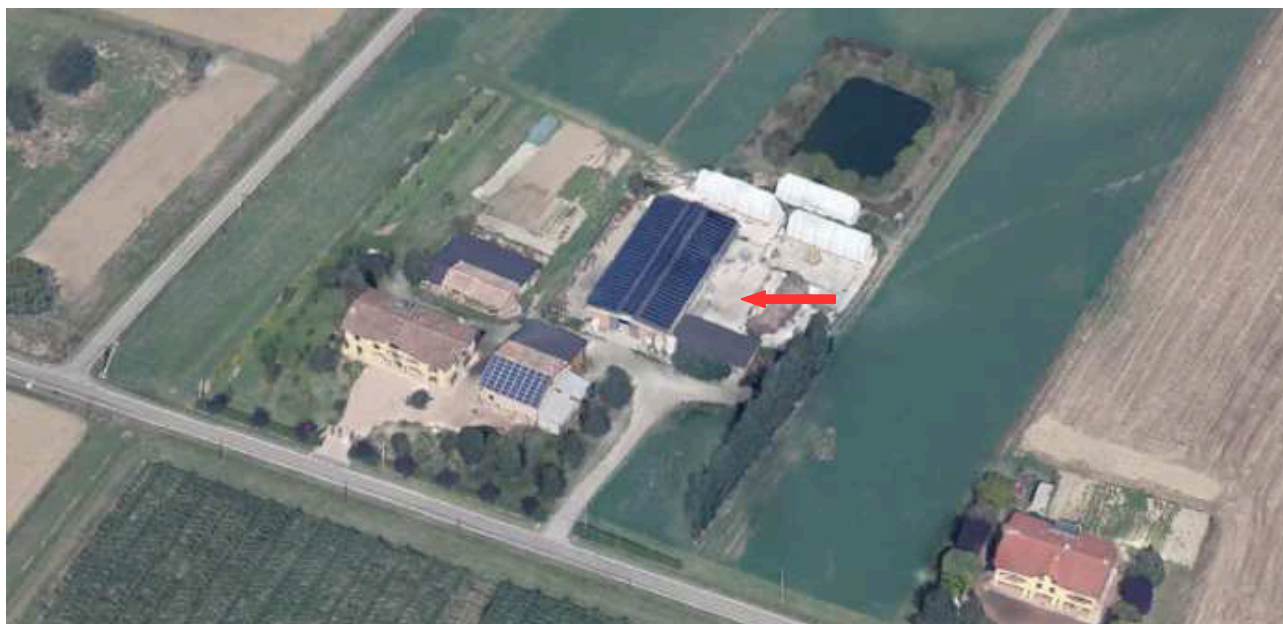
Vista del fabbricato da sud est (Fonte Google maps)
