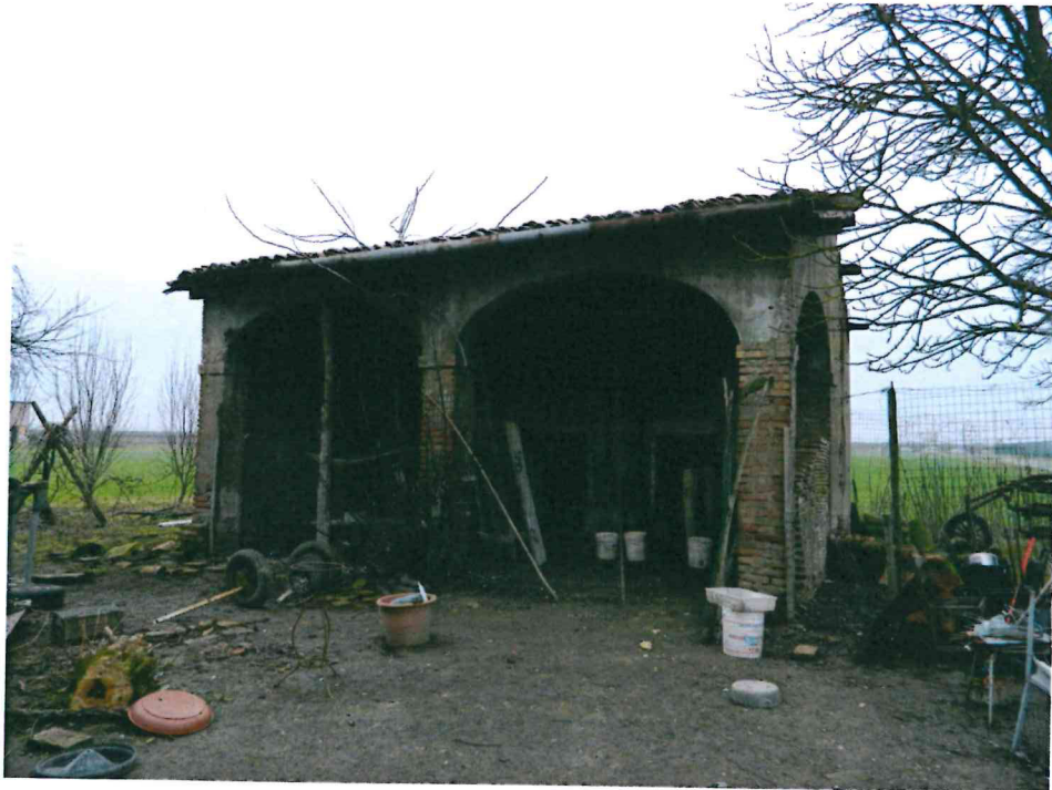
Vista fronte strada
